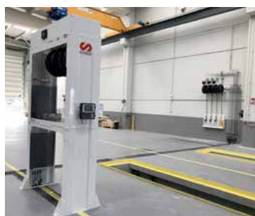
POSTES DE DISTRIBUTION
